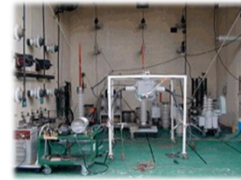
開閉器の負荷開閉試験
