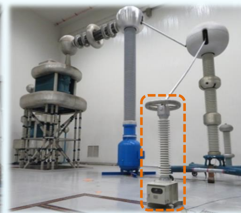
コンデンサ形計器用変圧器の 交流耐電圧試験
