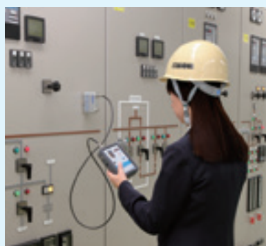
外壁から検出できます
