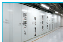
6.6kV Switchgear
