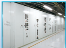
6.6kV Switchgear
