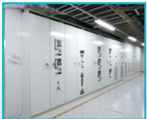
6.6kV Switchgear
