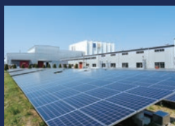
太陽光発電(自家消費)システム
