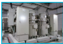
66/77kV ガス絶縁 開閉装置 XAE7(室内型)
