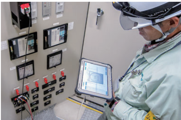
自動試験装置による点検作業
