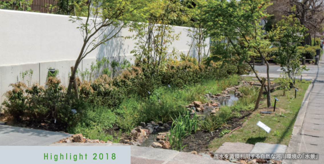
雨水をゆっくり地中浸透させる「雨庭」
